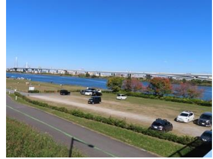
平井大橋で荒川を渡る
